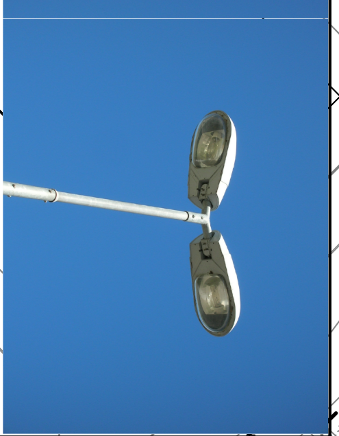
Tipologia Polo I.P. con armatura doppia
