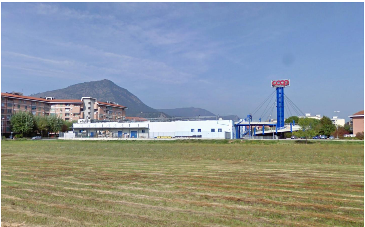
Foto 3 Vista del lato sud/est dell'edificio commerciale posto a nord dell'area di progetto.
