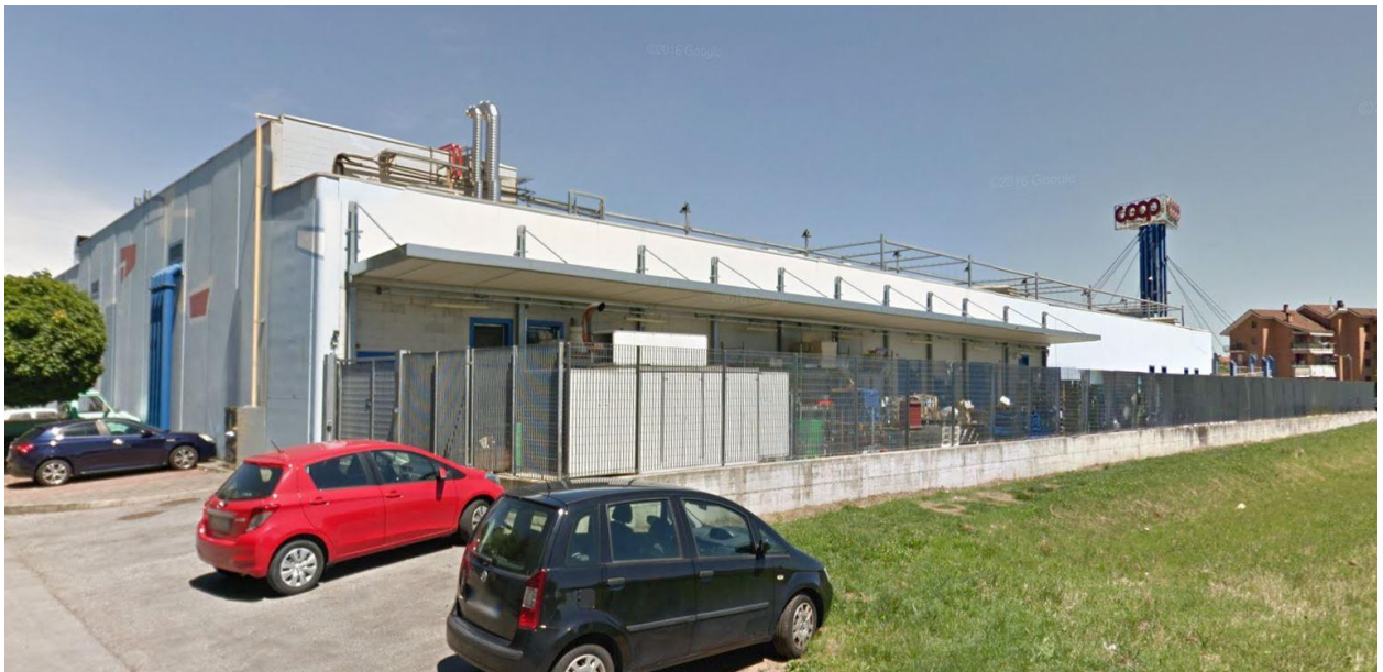
Foto 7 Vista degli Impianti del Supermercato Coop.
