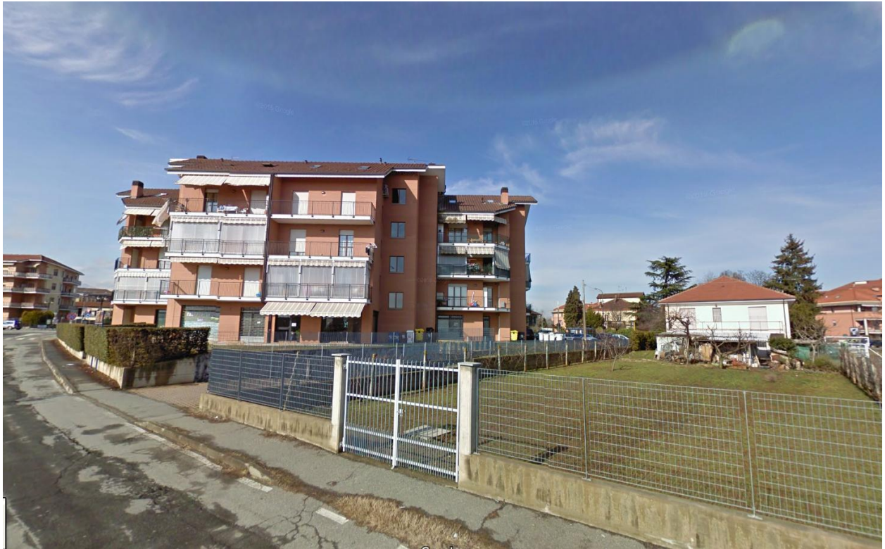
Foto 4 Vista del lato sud/ovest dell'edificio misto residenziale/commerciale a 4 piani in Via Chiabrera.
