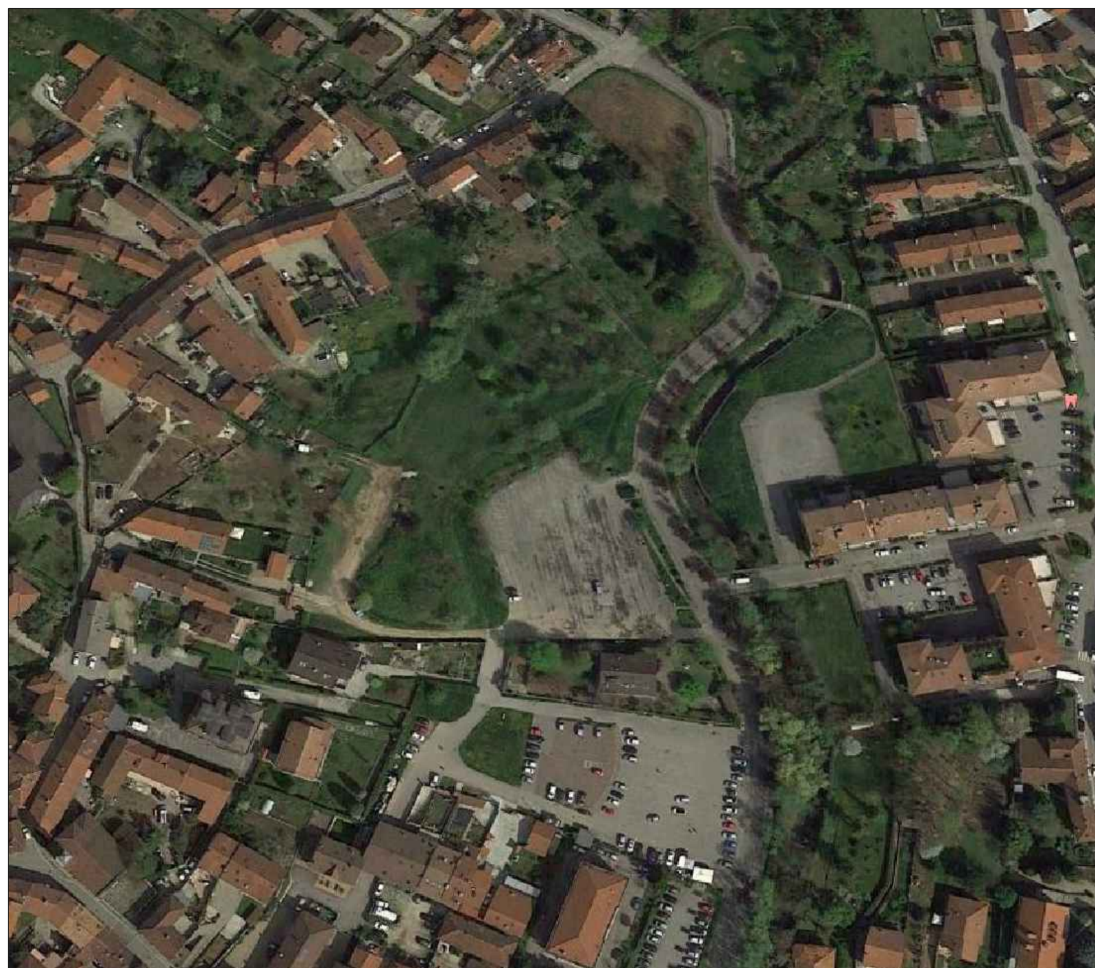
STATO DI FATTO: VISTA DALL'ALTO DELL'AMBITO DI INTERVENTO
