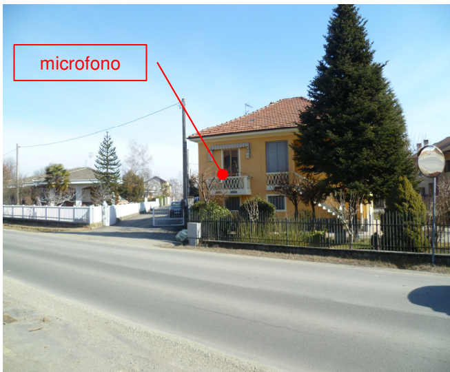
Figura 1 - Posizionamento del microfono sul balcone dell'abitazione in affaccio su Via Susa
