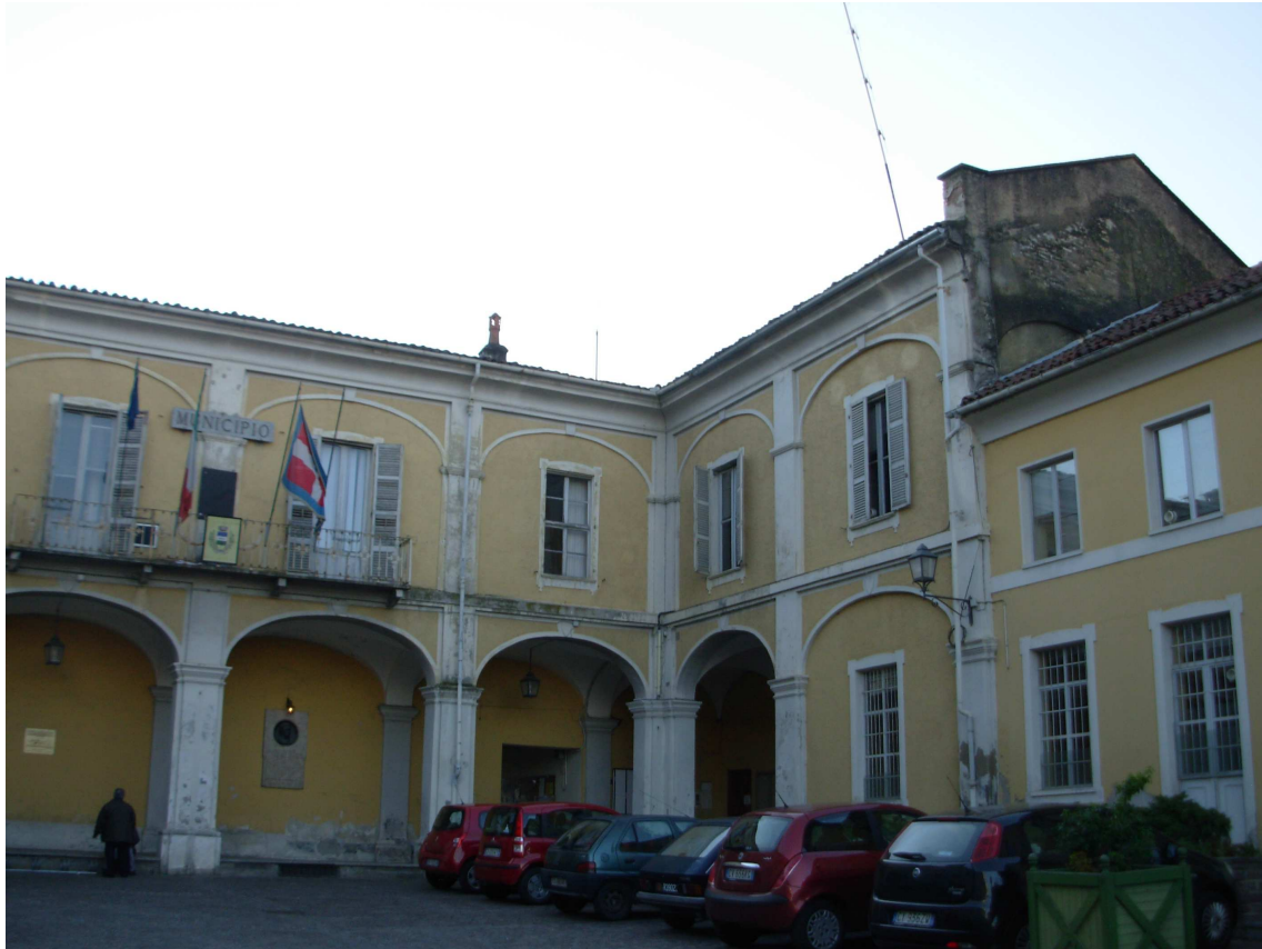
Giunzione tra corpo "A" e corpo "C"
