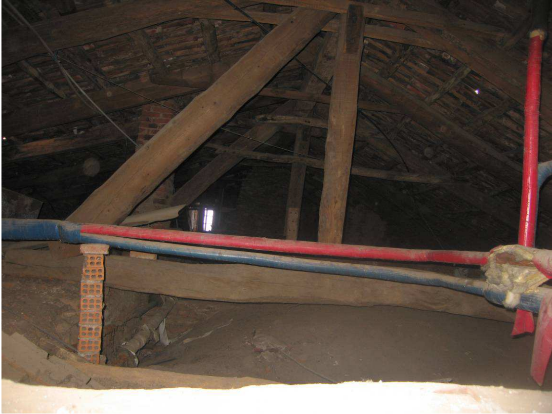
Struttura copertura in legno
