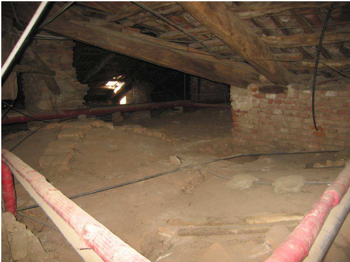
Struttura copertura in legno
