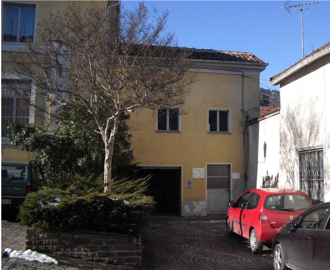
Volume da demolire prospetto su Piazza Tenente Nicola
