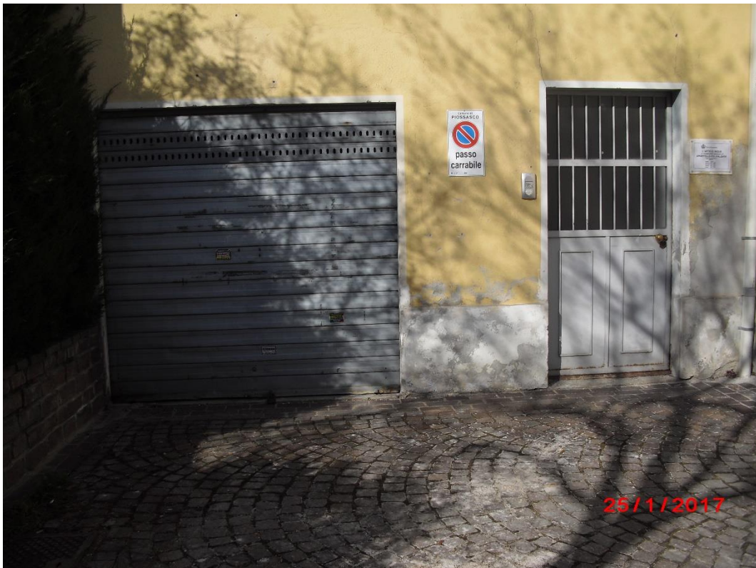
Particolare volume da demolire
