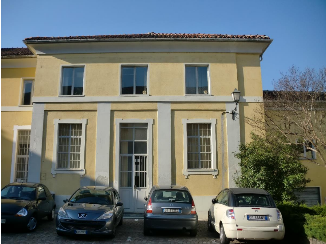
Vista porzione destra del prospetto su Piazza Tenente Nicola
