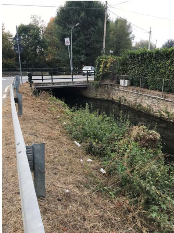
Fotografia 5 – Vista verso attraversamento di via San Rocco.
