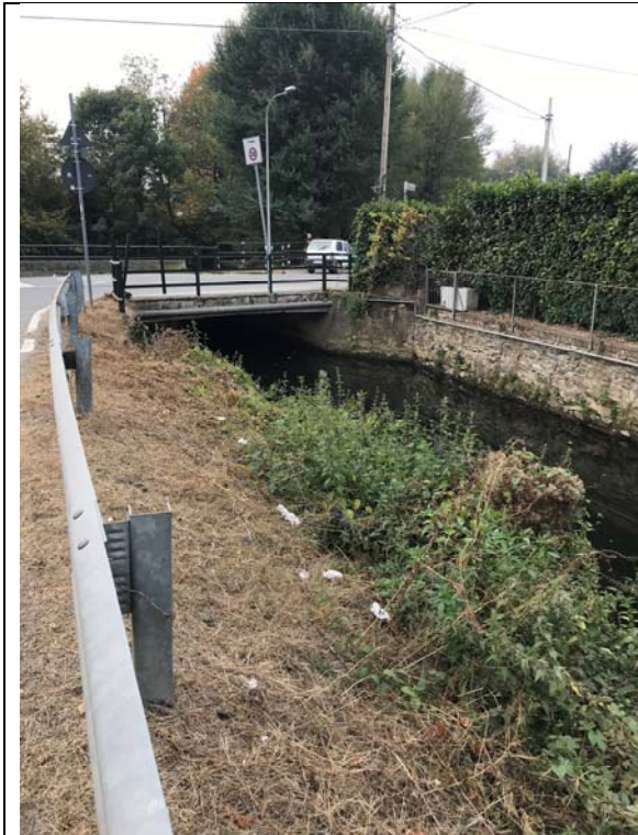
FOTO 3 – Vista da Via Piave verso l’attraversamento esistente di Via San Rocco.
