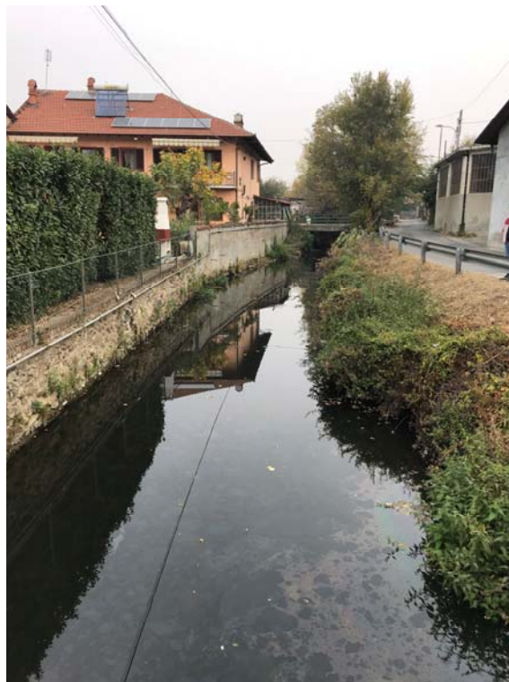
Figura 12 – Tratto oggetto di intervento.
